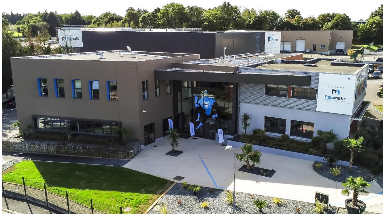
Légende : Façade de la société Palamatic Process avec l'agrandissement réalisé en 2023.
